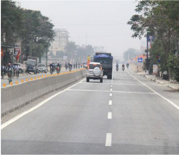
Hình 1.2. Hiện trạng tuyến đường Quốc lộ 1A đoạn qua khu vực dự án
