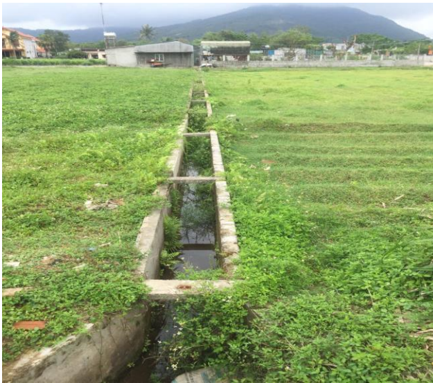
Hình 1.4. Hiện trạng tuyến mương thoát nước phía Tây khu vực dự án
