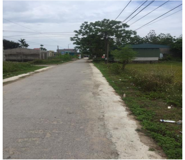
Hình 1.3. Hiện trạng tuyến đường giao thông phía Bắc khu vực dự án
