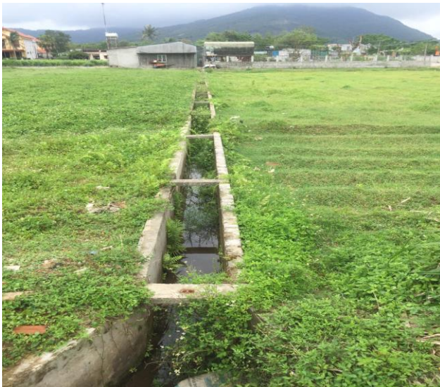
Hình 1.4. Hiện trạng tuyến mương thoát nước phía Tây khu vực dự án
